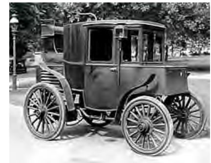
Riker Electric um 1900 mit 4 Radnabenmotoren
